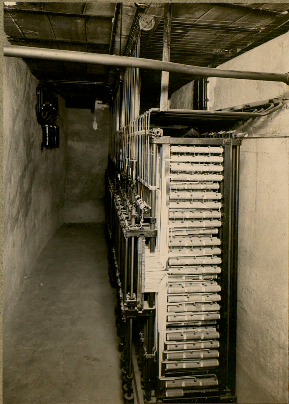
Widerstände im Keller, Stadttheater Luzern.
